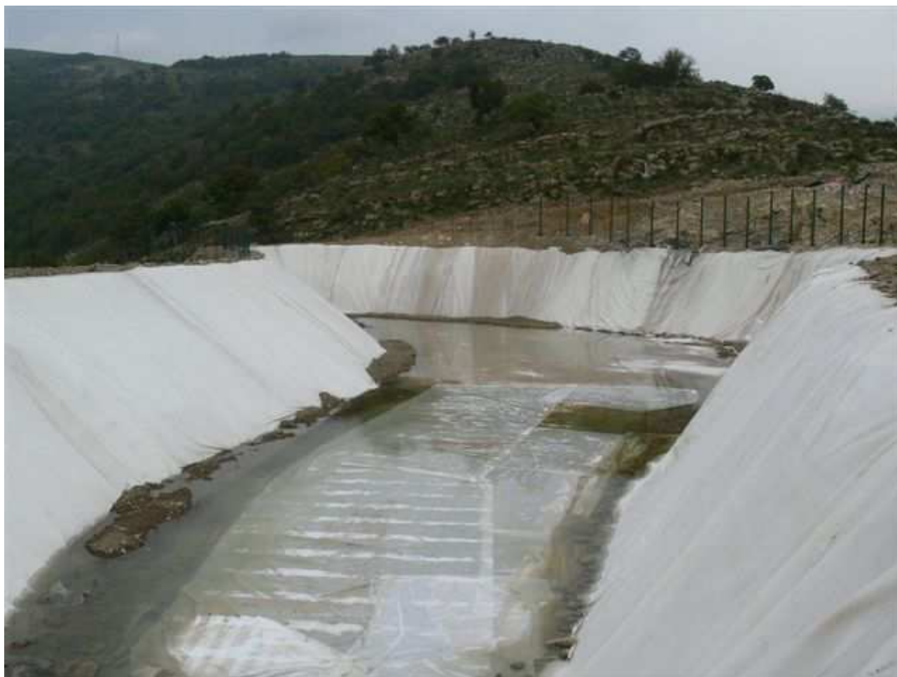
Panoramica del laghetto in corso di realizzazione.
