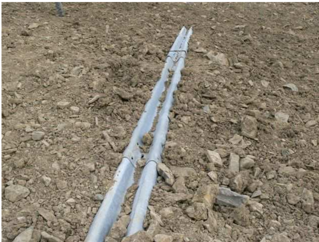
Particolare dei guardrail.
